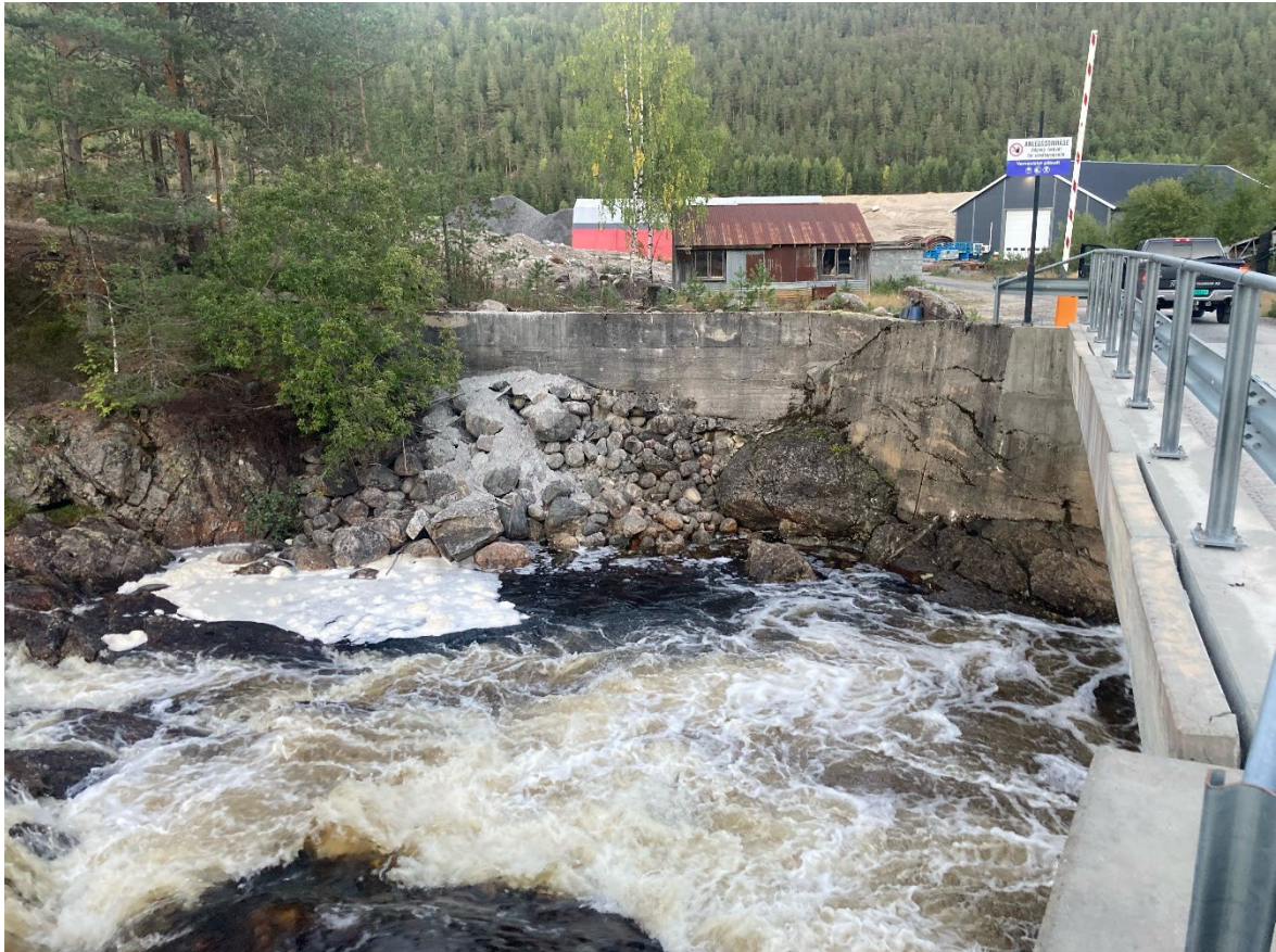
Bilde av flomvern ved oppstrøms brua.
