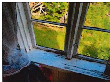
Bolig, vindu, eksempelilde
