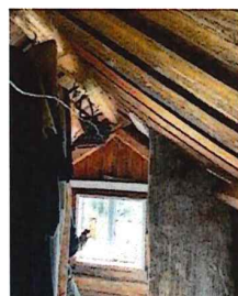
Bolig, loft, viser undertak og pipe lengst mot sør-øst
