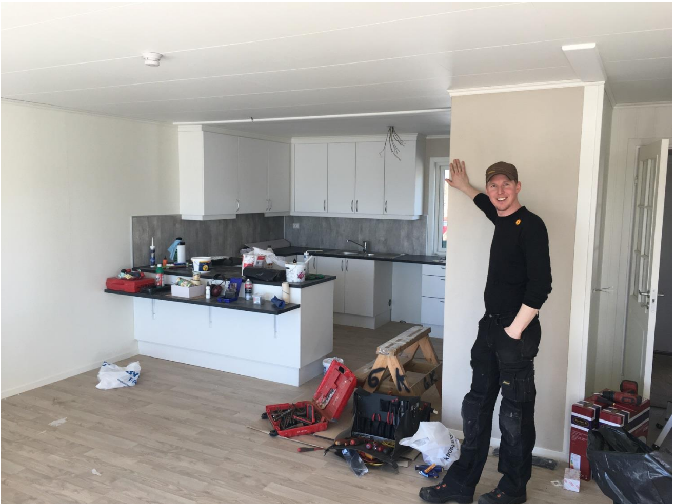
Fagarbeider i Gjerstad kommune, Tom Henry Valle, under arbeidet i en av utleieboligene.
